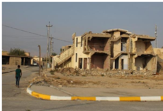
Zerstörtes Haus in Shingal Stadt
